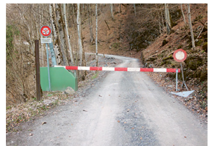
3 Absperrung einer Zufahrtsstrasse
