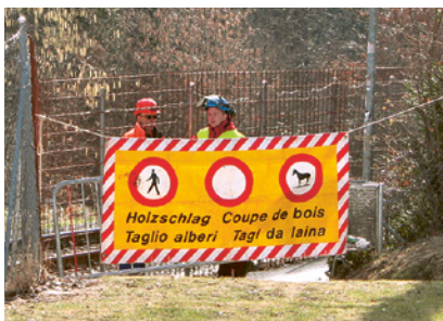
1 Absperrung eines Fusswegs mit einer Absperrplane
