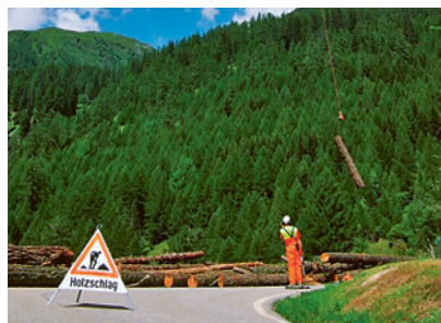
2 Sicherungsposten auf einer Zufahrtstrasse
